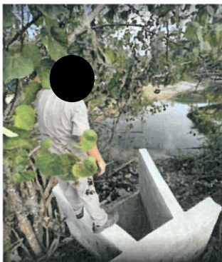
รูปที่ 2-5 แสดงรางระบายน้ำฝนส่วนเกินของโครงการ
