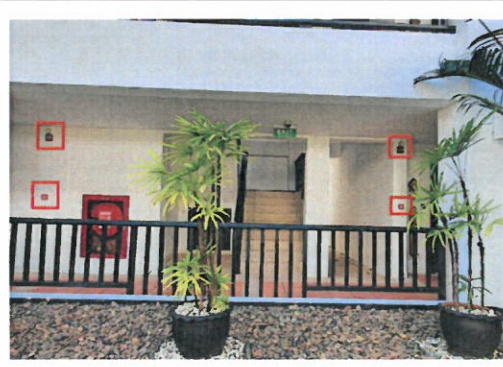
รูปที่ 2-25 แสดงตำแหน่งเครื่องตรวจจับความร้อน กริ่งสัญญาณเตือนอัคคีภัยพร้อมปุ่มกด ไว้ในห้องพัก และอาคารบริการของโครงการ
