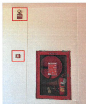
รูปที่ 2-25 แสดงตำแหน่งเครื่องตรวจจับความร้อน กริ่งสัญญาณเตือนอัคคีภัยพร้อมปุ่มกด ไว้ในห้องพัก และอาคารบริการของโครงการ
