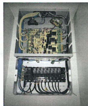
รูปที่ 2-20 แสดงระบบกฏญแจตัดไฟฟ้าในห้องพักของโครงการ เมื่อแขกออกจากห้องพัก
